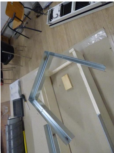
Figure 10 Top U shape metal edge
